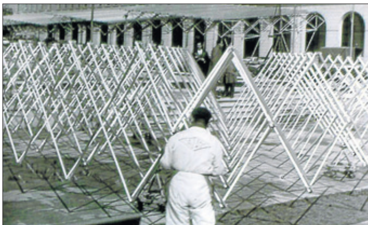
Montaje de un pabellón transportable, en 1964. ARCHIVO FUNDACIÓN
